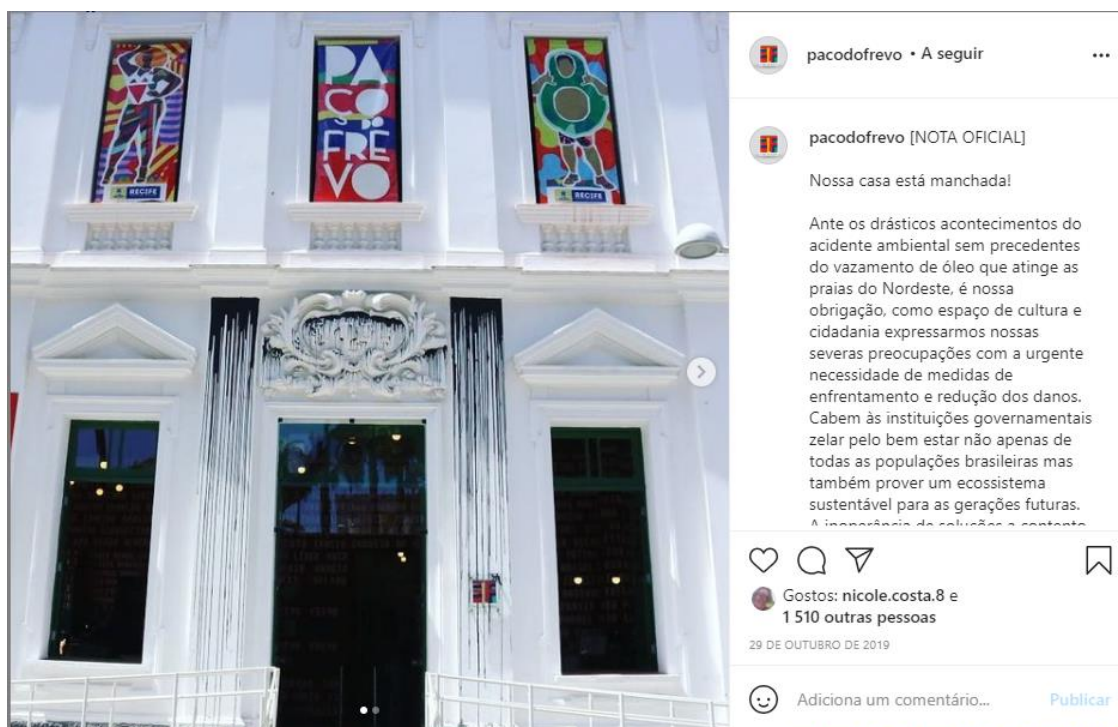
Figura 1: Intervenção “Nossa casa está manchada!”
